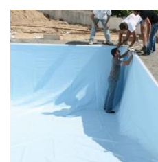
Τοποθέτηση liner και υποβρήχιου εξοπλισμού.
